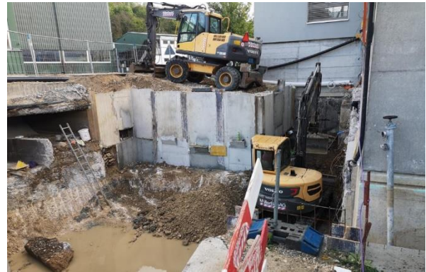
Abb. 25: Aushub und Felsabtrag Pumpenkeller
