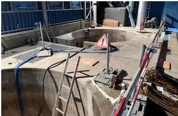
Abb. 26: bauliche Sanierung der Rundsandfänge
