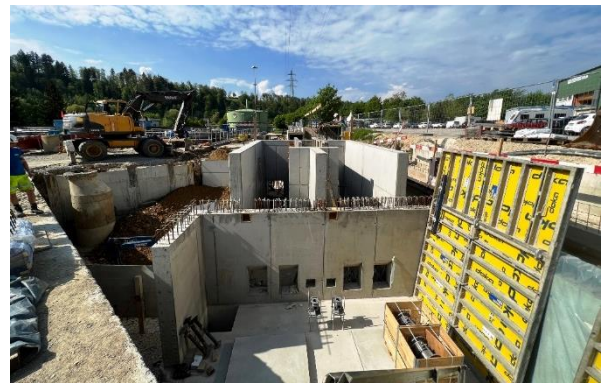
Abb. 21: Grobrechenkanal und Pumpwerk
