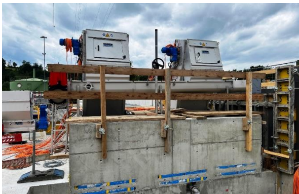
Abb. 22: zweistrassige Grobrechenanlage
